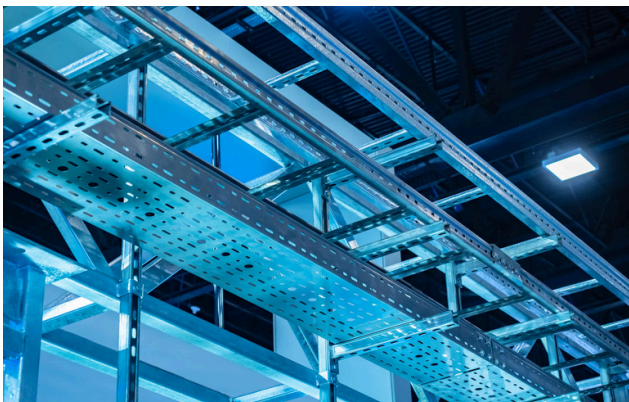
Montaža trasa za kablove
