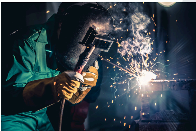
Radovi na varenju
